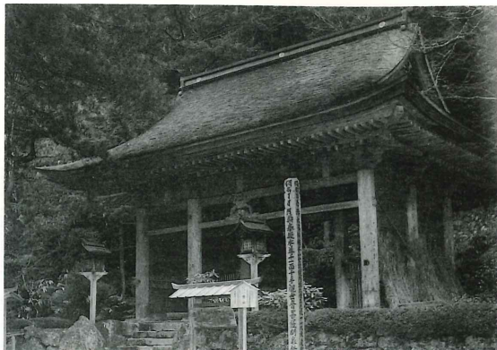
峰定寺 仁王門(重文)室町時代 洛北 花背に位置するこの仁王門は、普通八脚門と同様のものであるが入母屋造で屋根が高いため雄壮な感じとなっている。
