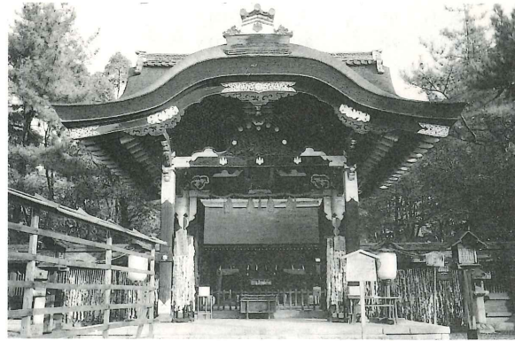
豊国神社 唐門(国宝) 安土桃山時代 四脚門で、伏見城の遺構とも伝えられ、暮股、門扉の彫刻、飾金具などが立派で桃山時代を代表する唐門といわれている。
