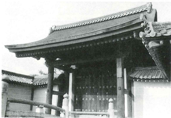
妙心寺 勅使門(重文)安土桃山時代 四脚門で総門の西に位置する。特に彫刻も少なく桃山時代としては簡素なつくりの門である。
