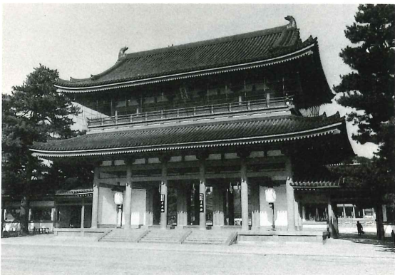
平安神宮 応天門 明治時代 平安京の応天門を模した二層入母屋造の楼門である。
