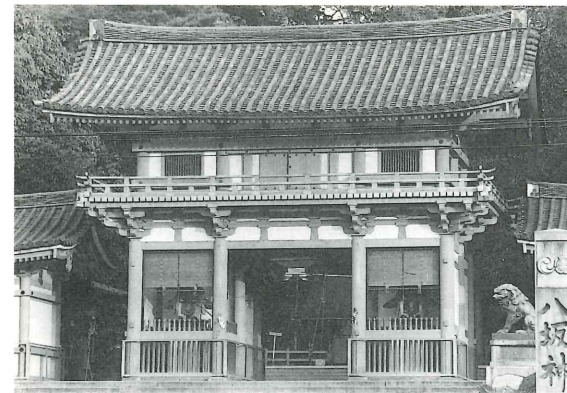
八坂神社 西楼門(重文) 室町時代 朱塗りで左右に大臣像を安置した楼門である。屋根が切妻造で左右に翼廊が見られることは、他の楼門と異なっている。
