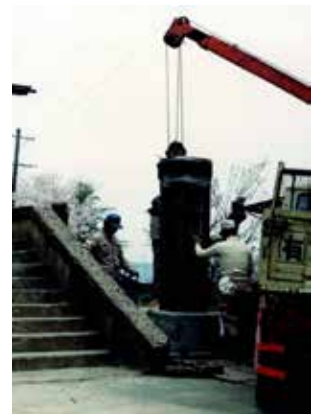
宮城県沖地震災害復旧工事（昭和 53 年度）
