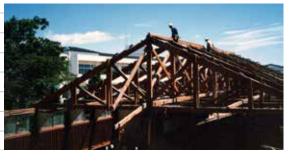
講堂解体作業（昭和 53 年度）
