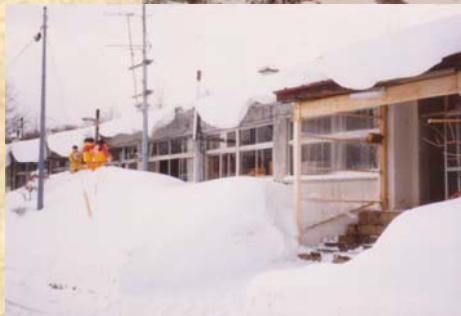
H10年頃の校舎 冬には校舎の屋根近くまで雪が積もる
