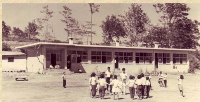
S35年 鉄筋コンクリート校舎新築
