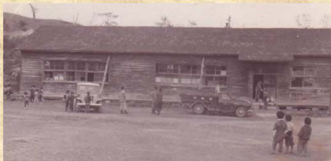
S25年11月落成 木造平屋建校舎 237㎡
