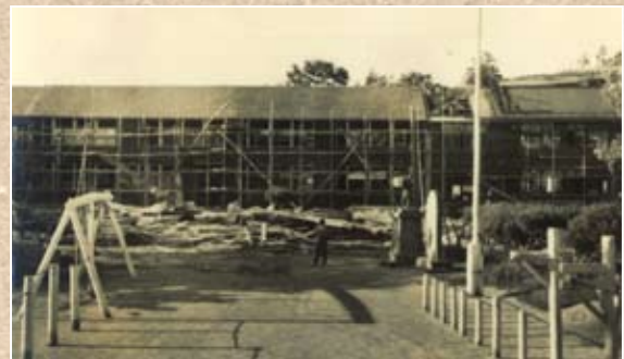
有賀小学校建築の様子
