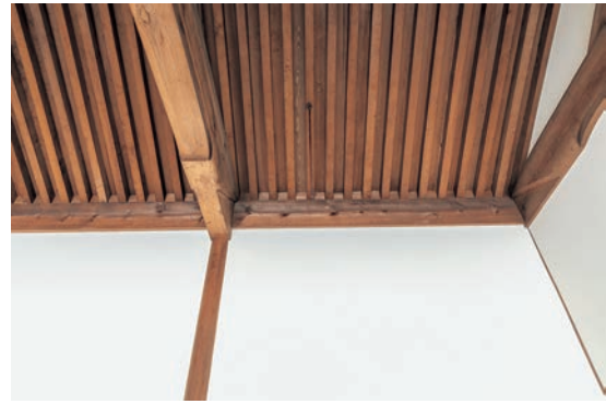
図14 飛香舎母屋燈楼の鈎金物
