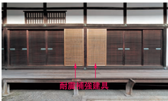
図27 耐震補強建具（舞良戸風）
