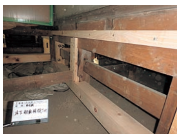
図30 床下補強木下地
