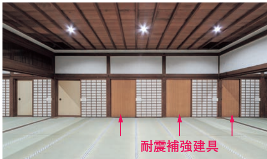
図25 耐震補強建具（板戸風）
