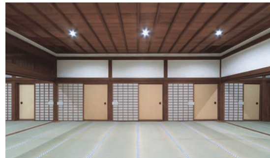
図26 耐震補強建具（障子を引いた状態）
