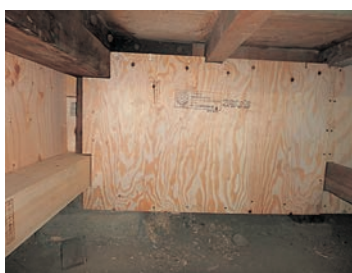
図31 床下構造用合板補強
