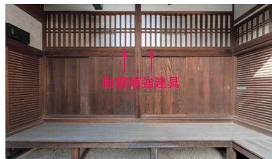
図28 耐震補強建具（障子風）
