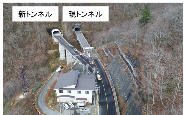
群馬県側坑口付近（R3.11）
