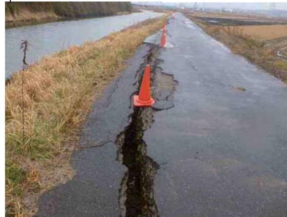
H23. 3. 11の地震時の液状化に起因する道路変状
