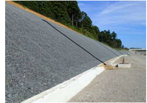
施工事例：東関道水戸線 (鉾田IC～茨城空港北IC)
