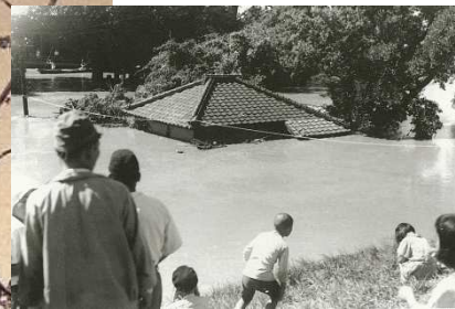
川口市内の浸水状況
