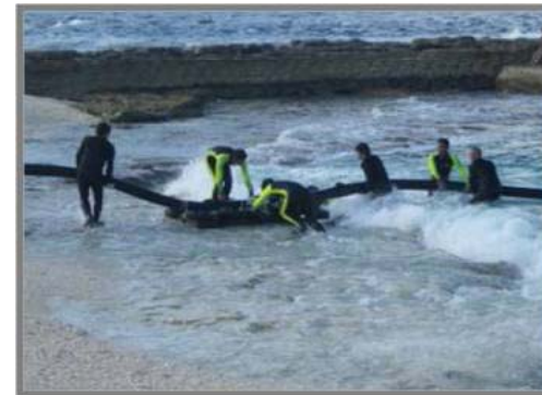
海浜でのホース取り付け (波浪により作業は難航)
