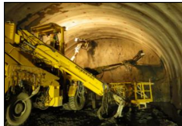
③丸滝トンネル
