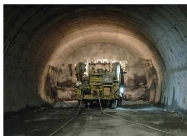
①樽峠トンネル
