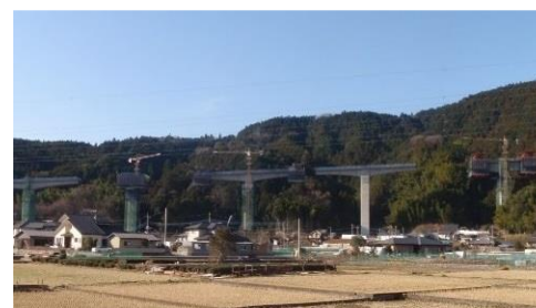
③平高架橋
