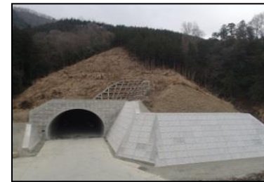
④醍醐山トンネル
