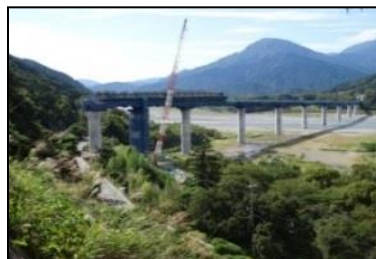
②富士川橋(南部町-身延町)
