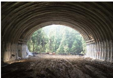
①楮根第2トンネル
