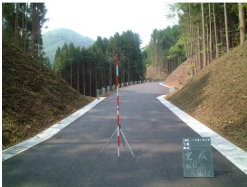
< 工事完成直後 >
