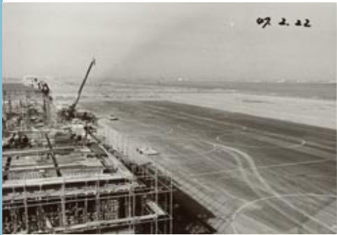
1972年2月22日撮影、建設中の東ヘリ。開港まで4ヶ月を切り、エプロンはほぼできた。写真提供:東京都港湾局
