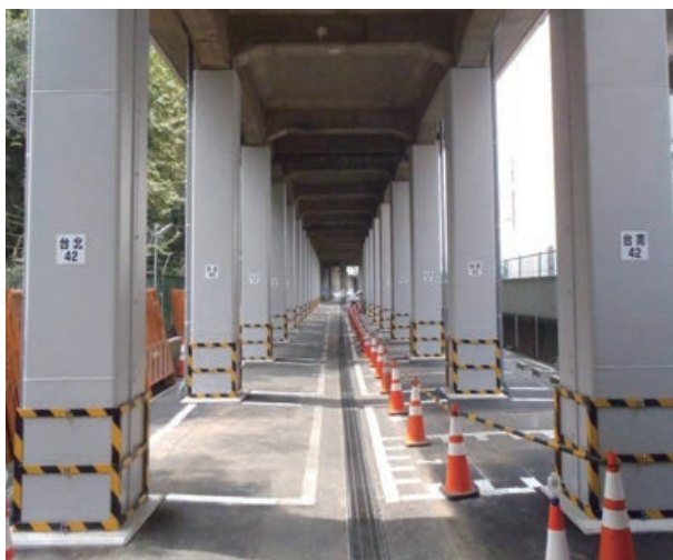
高架部の耐震対策
