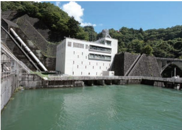
多摩川第一発電所
