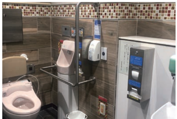
トイレの改修
