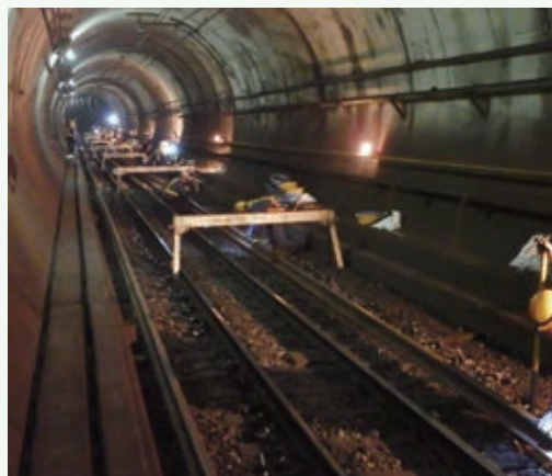
トンネル保守点検作業
