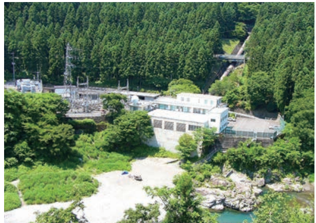
多摩川第三発電所
