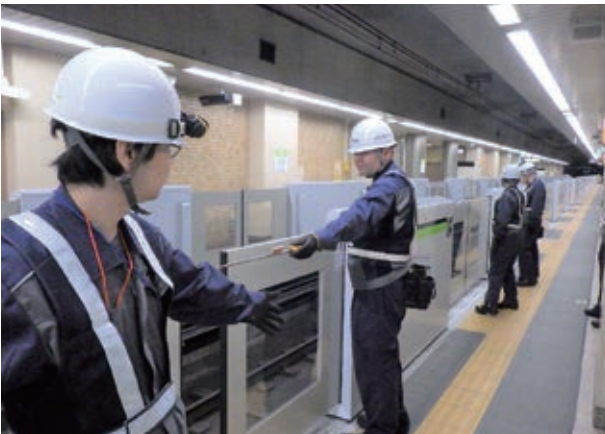
東京交通サービス(株)によるホームドア保守点検
