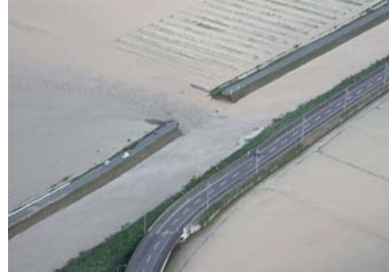
写真-1 破堤状況（野木川）
