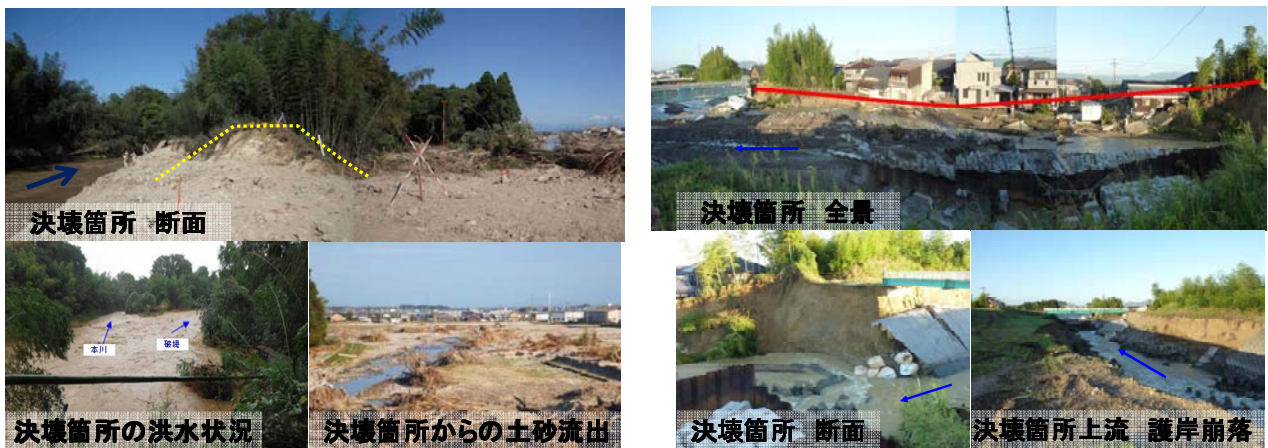
図2 決壊河川の被害状況(左:鴨川、右:金勝川)
