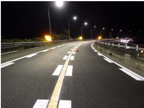
写真-7 FFP施工直後路面状況（大道カーブ）
