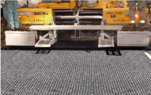
写真-1 専用フィニッシャによる敷均し状況例
