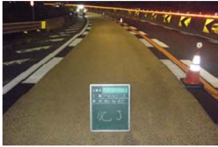
写真-4 すべり止め舗装の施工例
