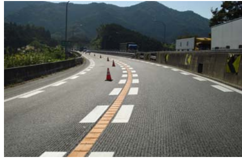
写真-6 FFP施工直後路面状況（米谷カーブ）
