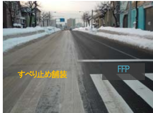
写真-8 路面露出状況
