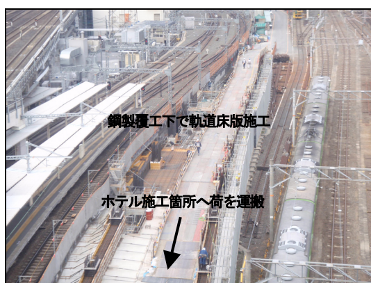
写真-4 鋼製覆工通路
