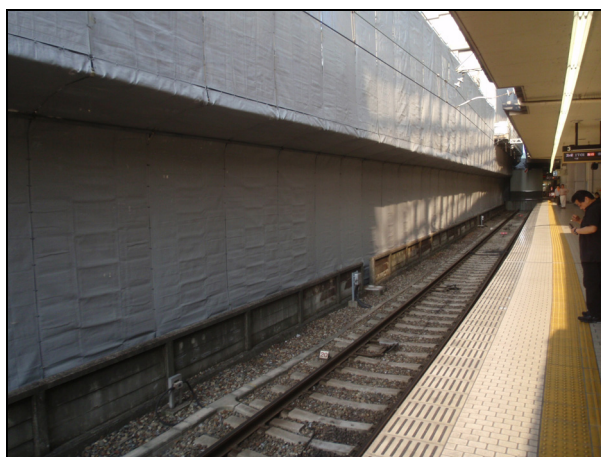
写真-7 近鉄線に対する防護設備
