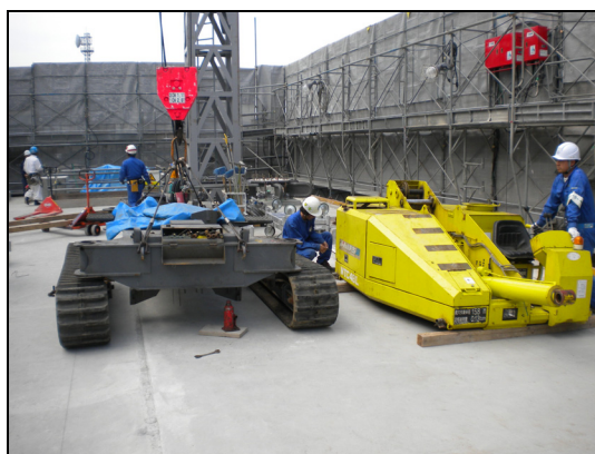
写真-3 組立式クローラ クレーン
