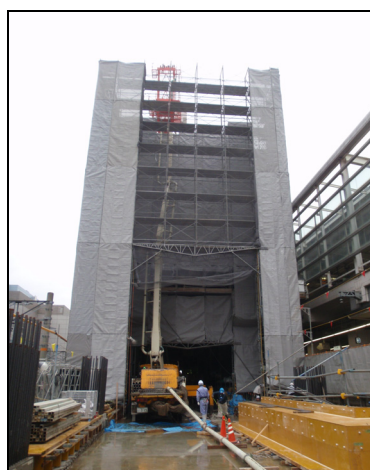
写真-6 中継ポンプ車による打設状況
