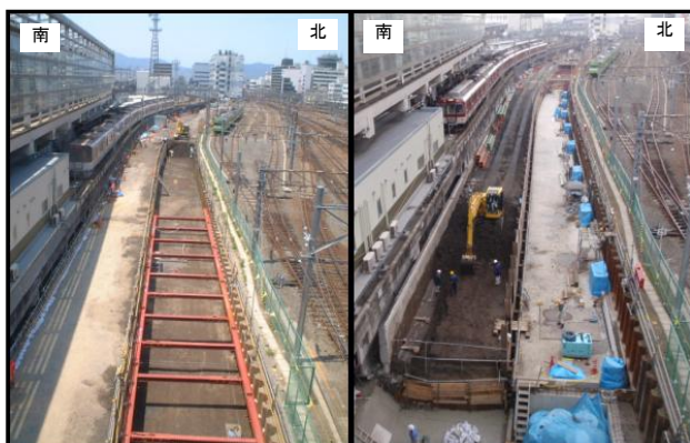
写真-1 (左)北側・(右)南側施工状況
