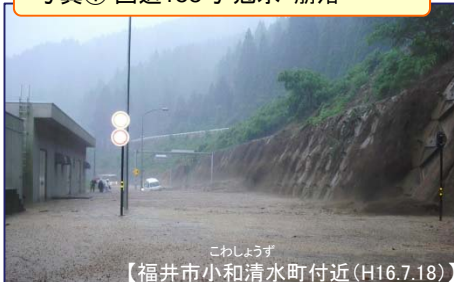
写真① 国道158号 冠水・崩落
