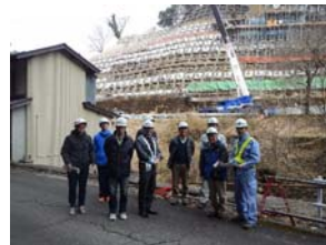
集合写真(アンカー工事前)
