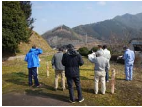
工事現場視察状況(対岸より)
