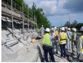
のり面補強工事視察状況
