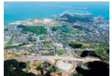
苅田・北九州空港インターチェンジ (2005年8月)
