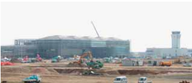
建設中の新北九州空港旅客ターミナルビル (2005年10月)
