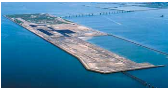
アスファルト舗装で滑走路・エプロンが見えてくる（2004年6月）
