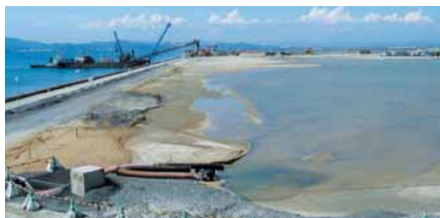
埋立工事現場（2000年8月）
