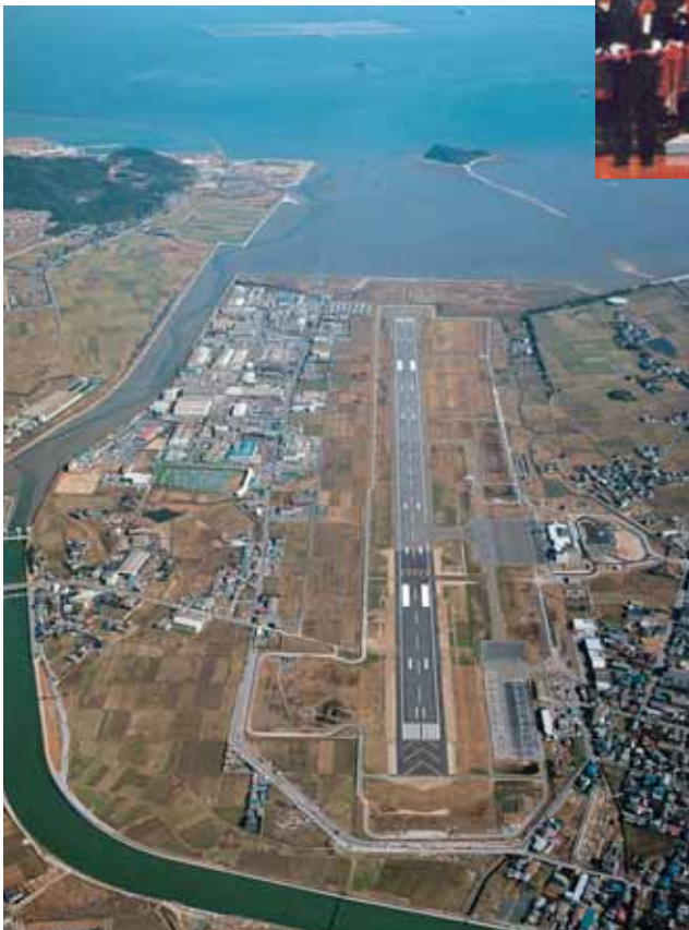
滑走路延長工事が完了した旧北九州空港（1991年頃）
