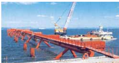
北側の進入灯橋梁工事（2003年10月）
