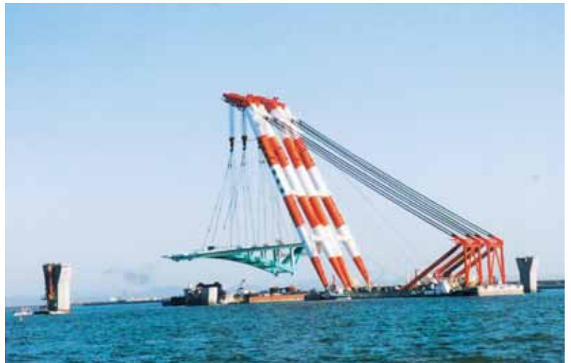
新北九州空港連絡橋工事 (1999年10月)
