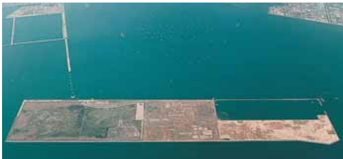
第2工区地盤改良工事（2003年7月）
