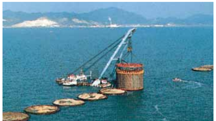
関門航路、新門司航路、苅田港航路の浚渫土砂処分場として、 苅田沖土砂処分場の第1期工事着工(1977年7月)
