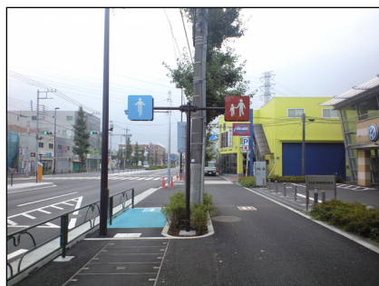
図 7-2 自転車走行部分はアスファルト舗装
