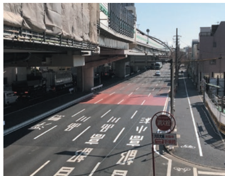
旧産業道路踏切部の道路復旧完了
