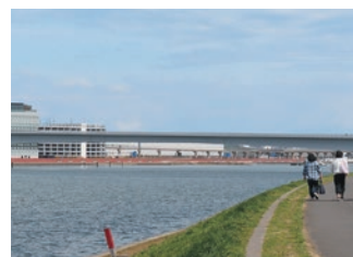
多摩川スカイブリッジ
