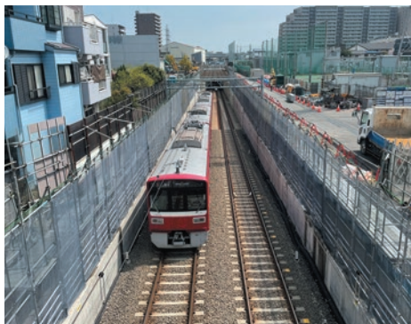
地上部整備の現状
