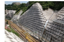
法面防護工事
