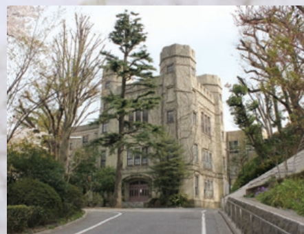
1929(昭和4)年4月、J. H. モーガンの設計により竣工した中学部本校舎 老朽化が著しく意匠を継承した建物に建て替えるため2016年8月に解体
