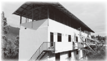
建設中の新しい女子寮
