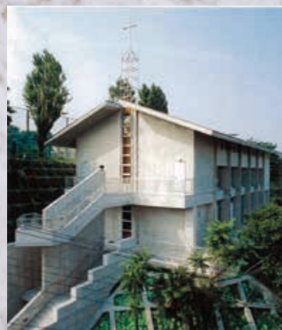
坂田記念館（1990年6月5日完成） 鉄筋コンクリート造二階建、 総延床面積573.55㎡、高さ11.1m
