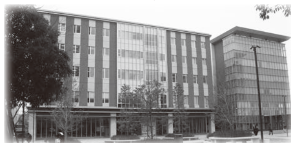
2017年竣工の大学3号館
