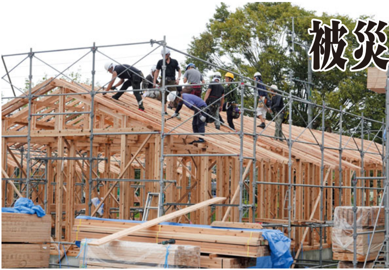
協力して仮設住宅を建設する
