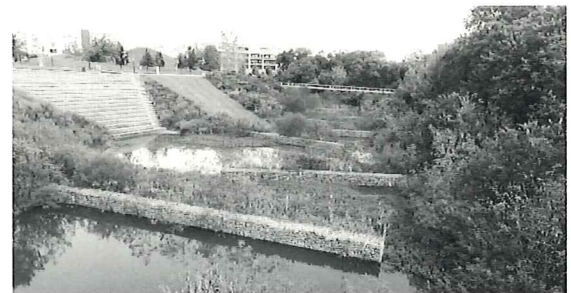
■貯水量増加と水質浄化 @Renaissance Park
