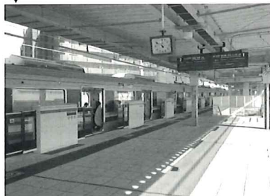
二重引き戸式ホームドアと石畳風ホーム舗装
