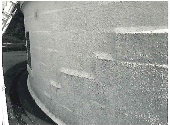
■阪神・淡路大震災で被災を受け、石積みをもルタルで補強復旧している
