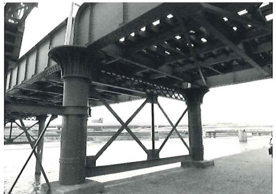
■大和川橋梁(下部)
