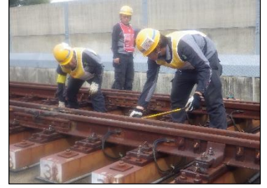
【工務関係技能競技会(分岐器)】
