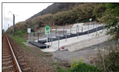
〔津波避難階段(2020年度新設)〕
