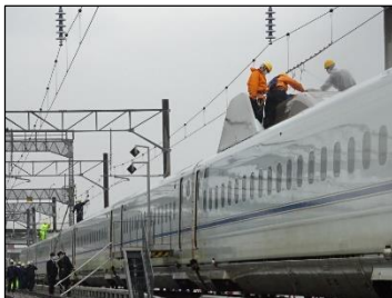
【パンタグラフ緊縛訓練・電車線復旧訓練】
