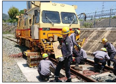
【保守用車脱線復旧競技会】
