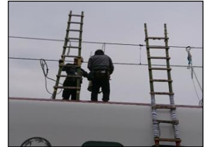
【車両上での電車線復旧訓練】
