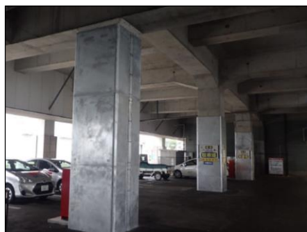
〔鋼板巻立補強工法(行橋駅)〕
