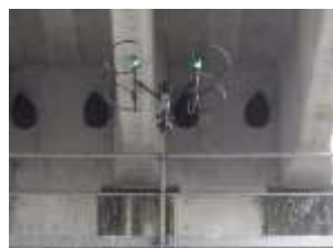
[ドローンによる構造物点検訓練]
