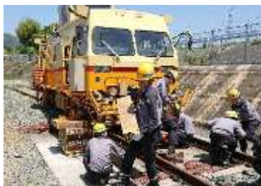
[保守用車脱線復旧競技会]
