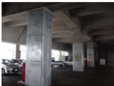
[鋼板巻立補強工法(行橋駅)]
