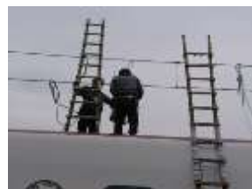
[車両上での電車線復旧訓練]
