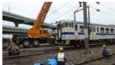
[クレーンによる列車の載線(本社直轄)]
