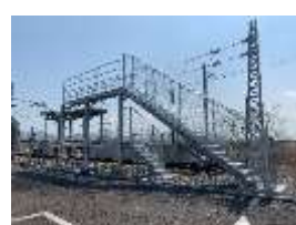
[車両屋上機器点検台]
