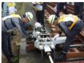
[工務関係技能競技会(分岐器)]
