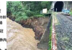
【線路流失】 根室線 落合～新得 広内(信)第2谷間川橋りょう
