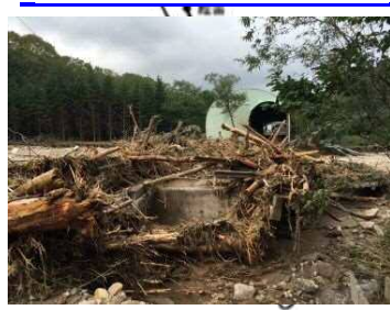
【線路流失】 根室線 落合～新得 広内(信)第2谷間川橋りょう
