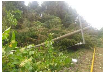
【倒木・電柱折損・電線切断】 函館線 大沼～長万部 約200本の倒木処理中 電線接続中
