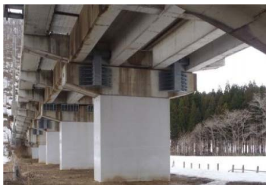
共用区間のRC橋脚の鋼板巻き補強
