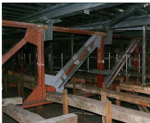
小樽駅の耐震補強工事（平成24年4月竣工）
