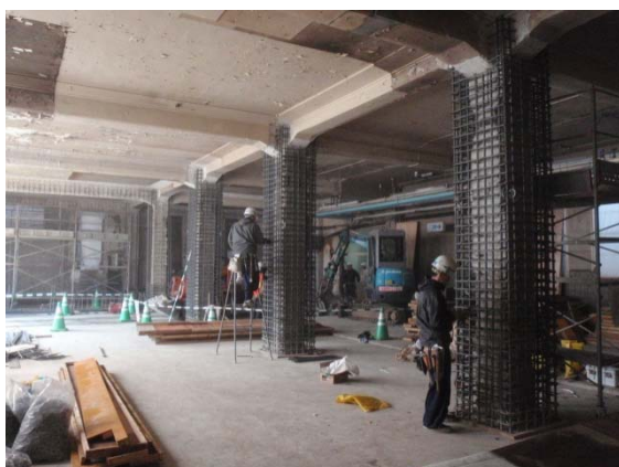
小樽駅の耐震補強工事（平成24年4月竣工）
