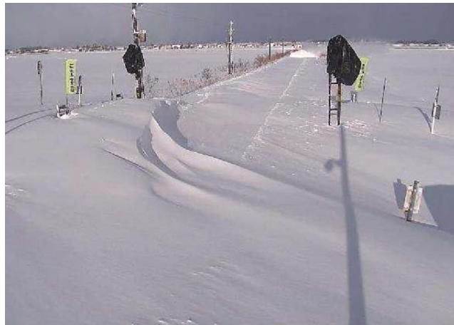
降雪モニターカメラ映像による吹き溜まり 状況の把握(室蘭線 志文駅～岩見沢駅間)
