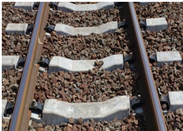
PCマクラギ化（根室線）
