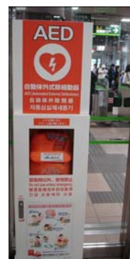
駅に設置しているAED
