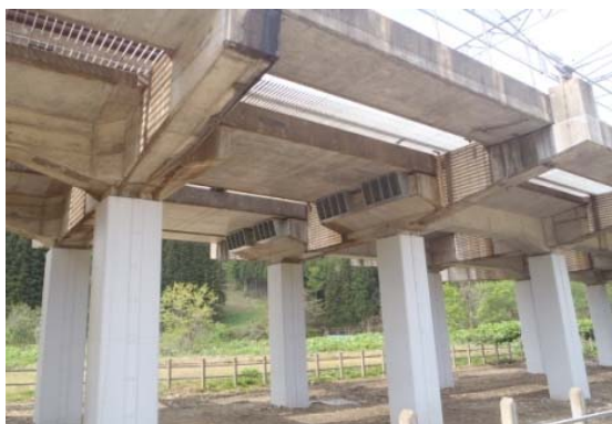
共用区間のRCラーメン高架橋柱の鋼板巻き補強
