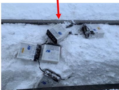
(落下したバッテリー)
