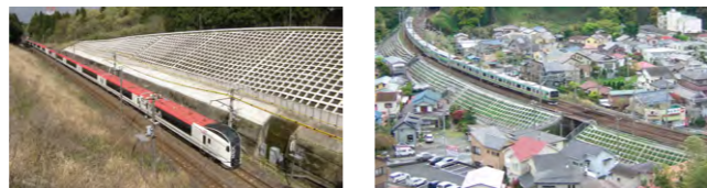
切取りのり面(吹付砕工) 盛土のり面(吹付砕工)
