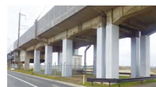
高架橋柱耐震補強
