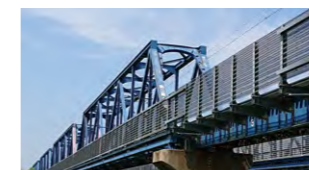
羽越本線 北余目～砂越間
