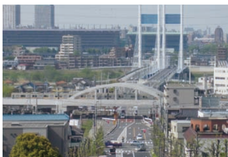
南武線稲城長沼駅付近高架化
