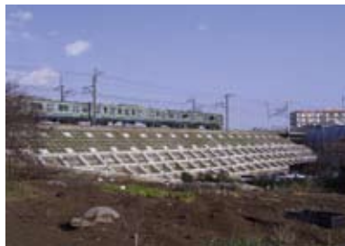
コンクリート製の格子砕工
