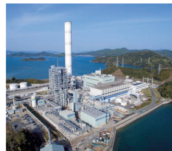
大崎クールジェン （酸素吹IGCC実証試験発電所）
