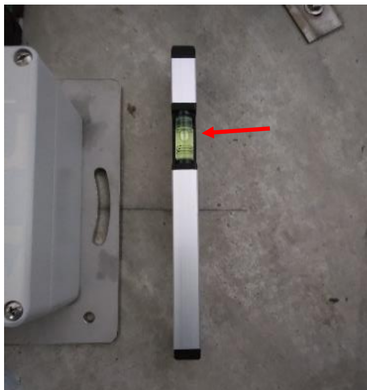
震度計台の傾き
