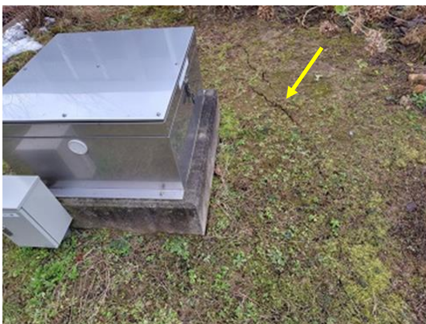
周辺地盤のひび割れ
