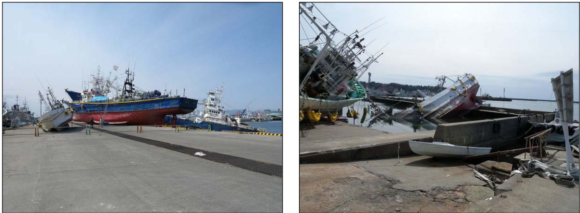
写真 48 小名浜漁港の被害状況
