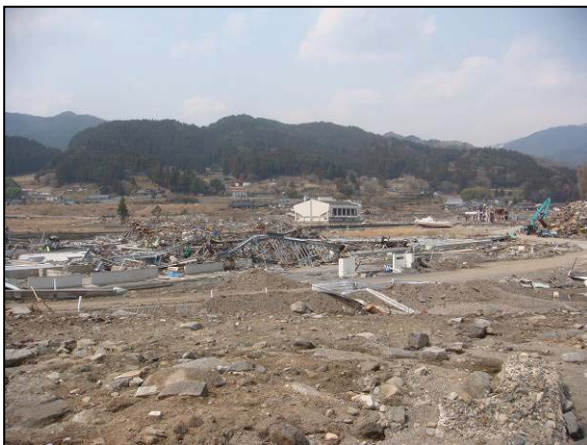
写真 13 大船渡市三陸町越喜来地区の被害状況
