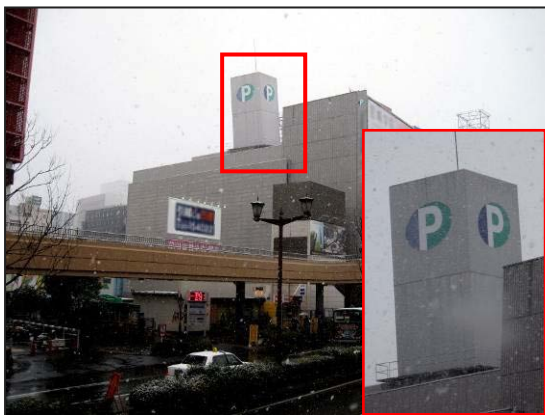
写真 5 仙台市青葉区 仙台駅西口のパーキング屋上の傾いた構造物
