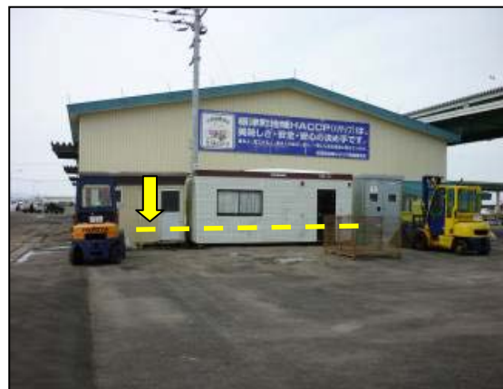
写真 1 津波の痕跡（図 3 の 1）
