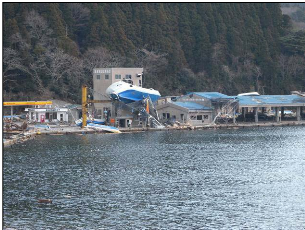
写真 20 漁港外側の漁協施設の被害状況
