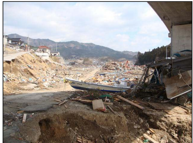
写真 21 漁港の陸橋下から見た綾里町の被害状況
