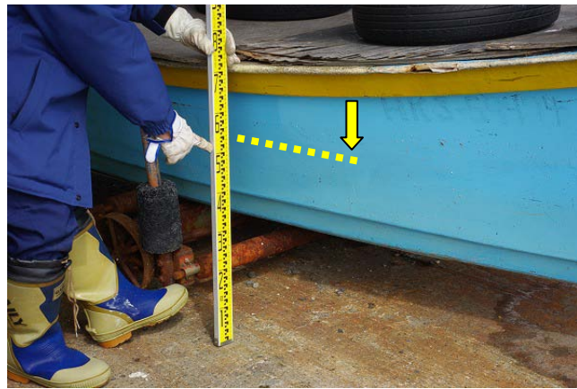
写真 15 津波の痕跡（図 21 の 15）
