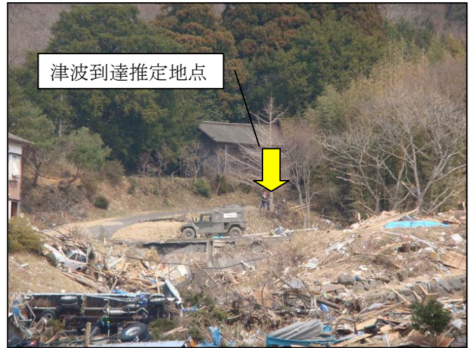
写真 10 津波の痕跡（図 9 の 29）
