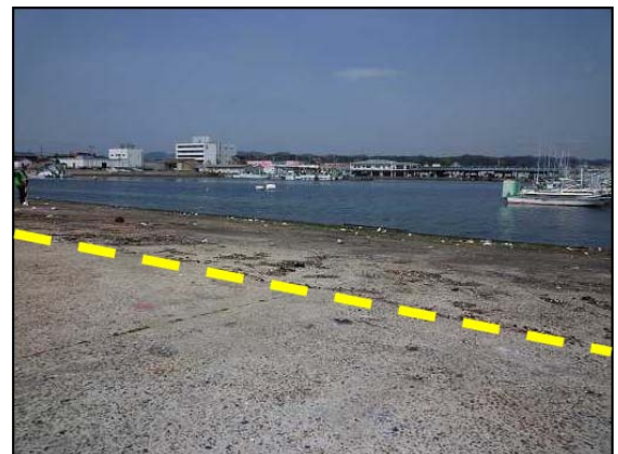
写真 6 津波の痕跡（図 9 の 66）
