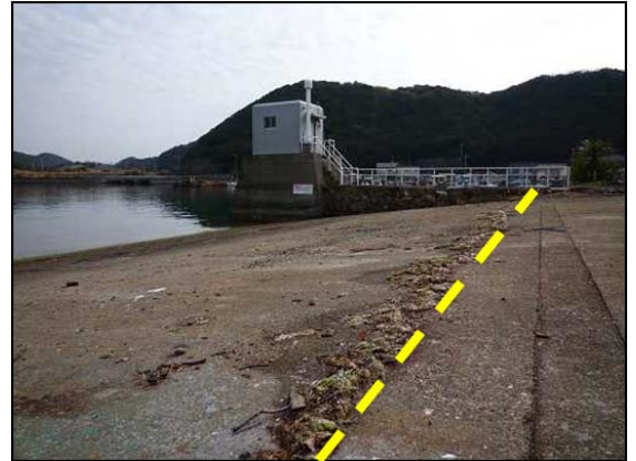
写真 7 津波の痕跡（図 10 の 67）
