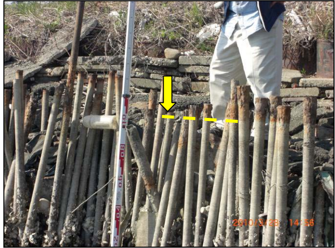
写真 1 津波の痕跡（図 3 の 61）
