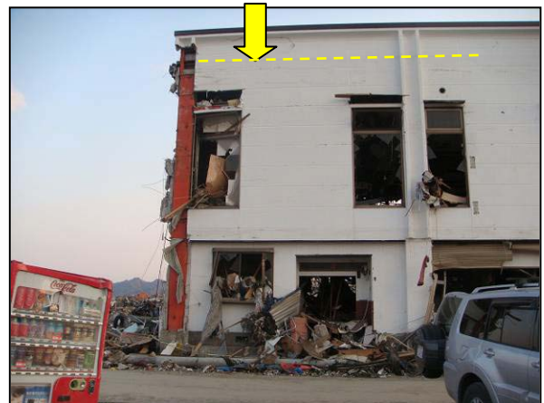
写真 30 津波の痕跡（図 15 の 35）
