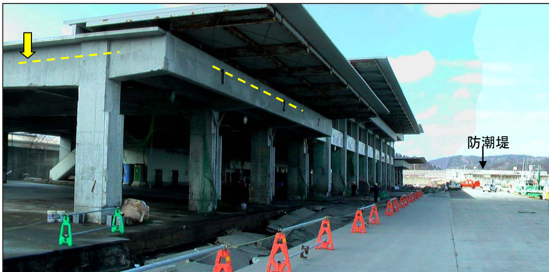
写真 3 津波の痕跡（魚市場外側の柱に痕跡、図 5 の 22）
