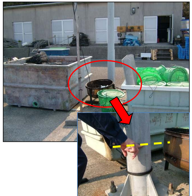
写真 16 津波の痕跡（図 21 の 76）
