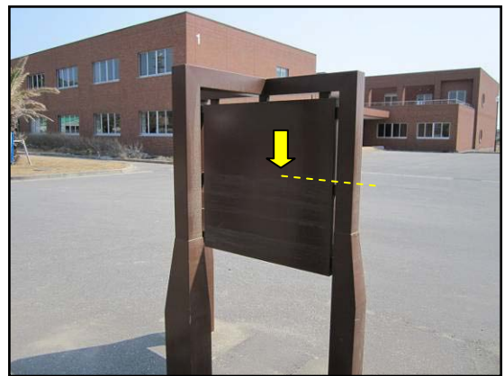
写真 14 津波の痕跡（図 17 の 58）
