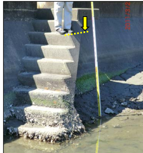
写真 2 津波の痕跡（図 4 の 62）
