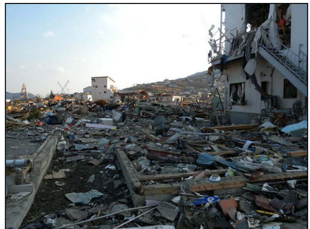
写真 32 大船渡市野々田地区の被害状況
