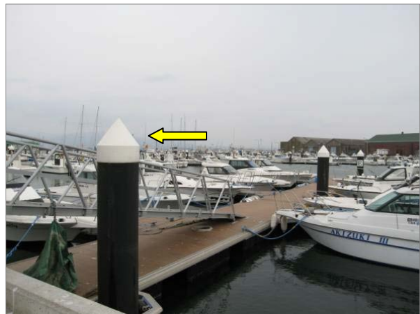
写真 20 海面の上昇により矢印まで浮き棧橋が上昇した（図 27 の 20）。
