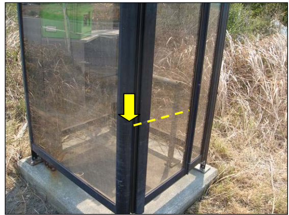
写真 11 津波の痕跡（図 16 の 57）
