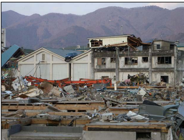
写真 31 大船渡市野々田地区の被害状況
