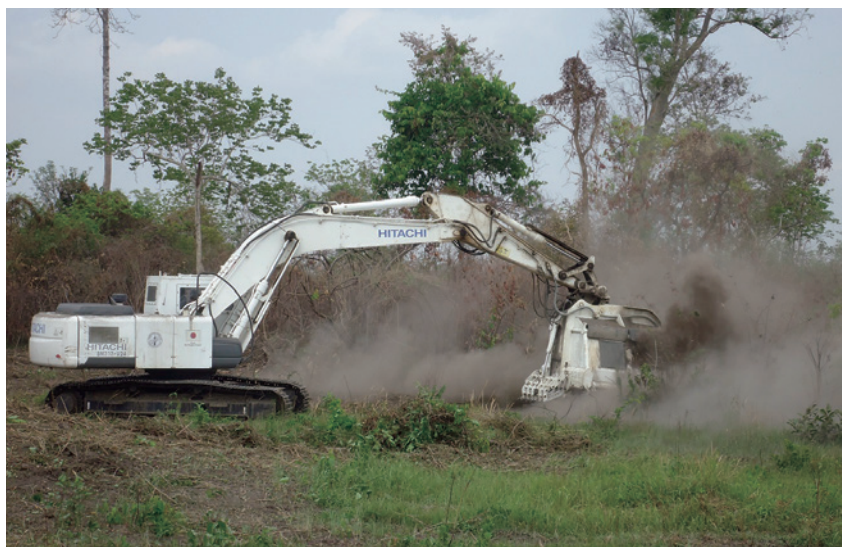
作業中の除去機
