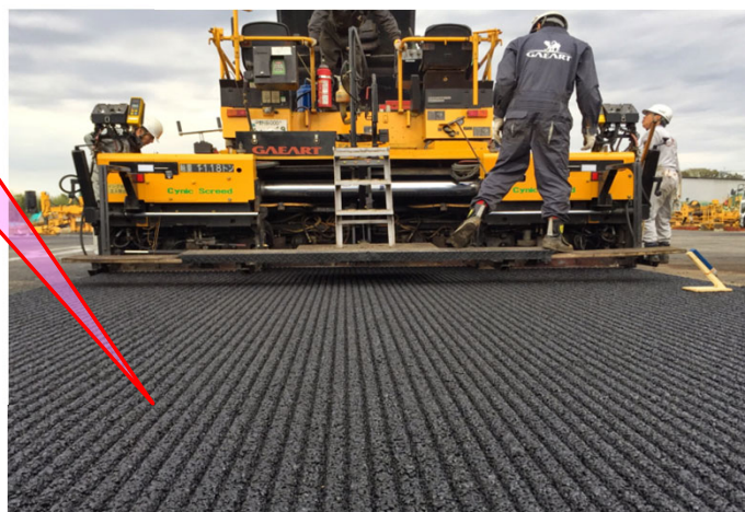
シニックスクリードによる敷均し状況
