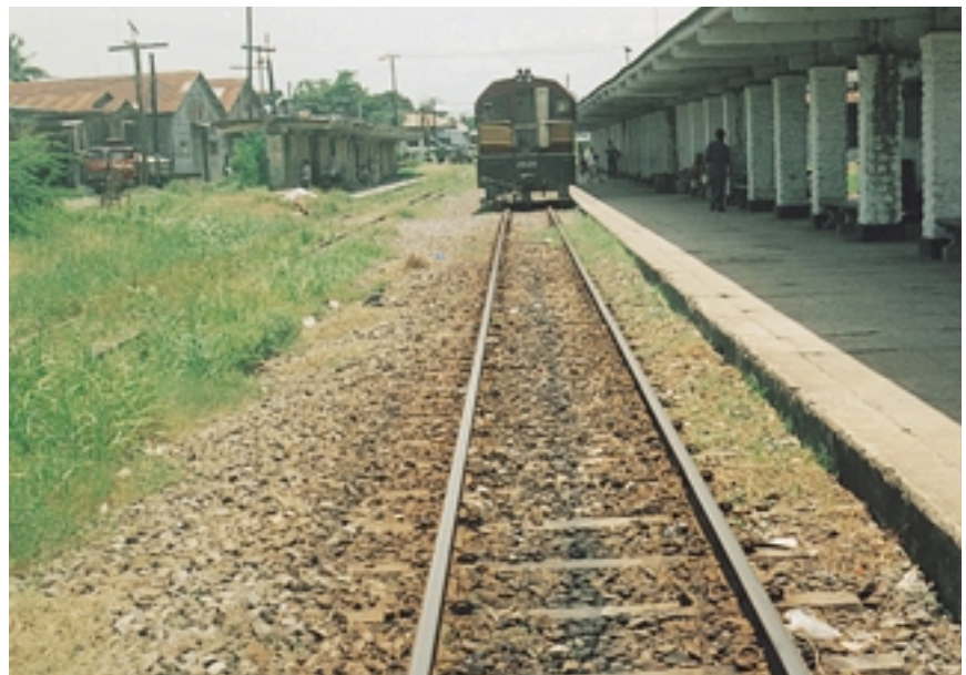
本事業により整備された軌道
