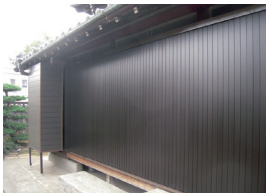
足立区某邸 横引きシャッター
