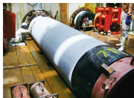
大阪府東部流域下水道事務所 圧送管推進
