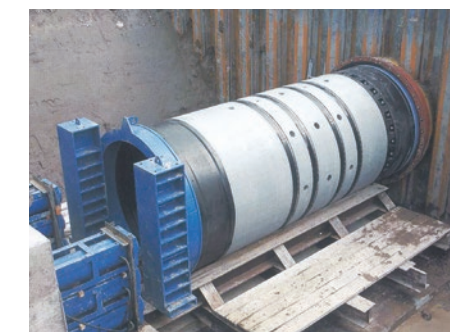
建設省大分工事事務所 排水樋管
