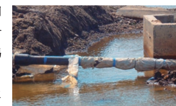
津波で流されなかった NS 形管
