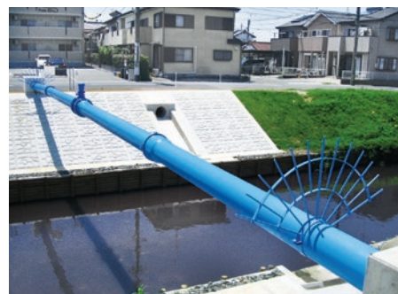
浜松市上下水道部 水管橋
