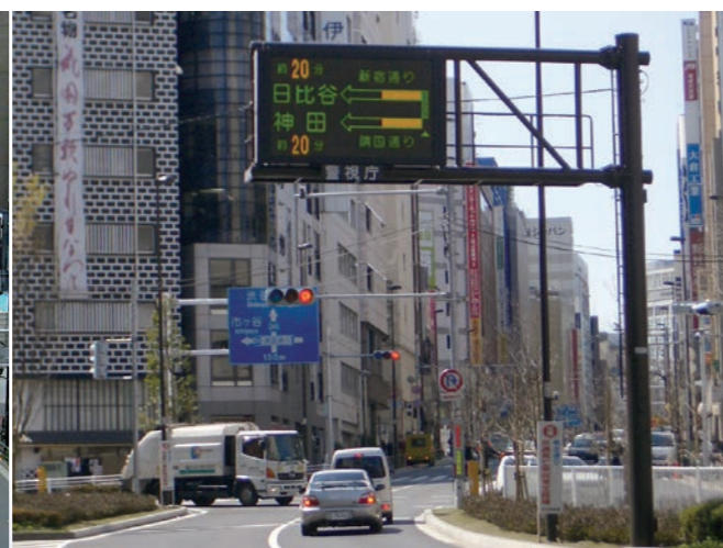
写真3 交通情報板の設置状況
