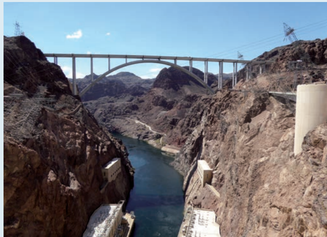
写真8 ダム下流に架かる通称コロラドリバー橋
