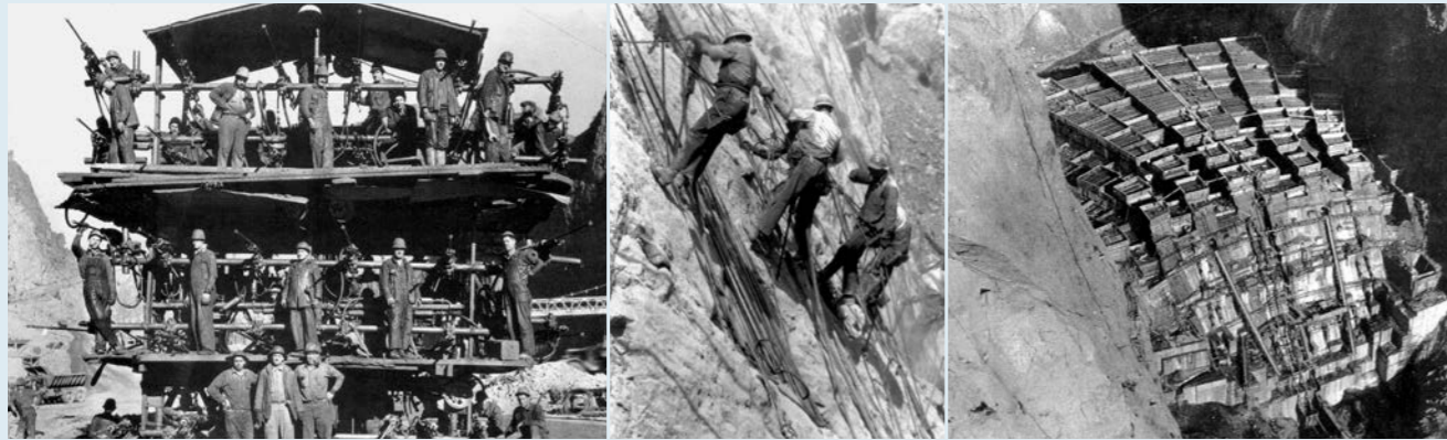
写真5 トンネル施工のドリルリグ「ジャンボ」
