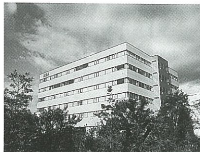
新技術開発センター棟
