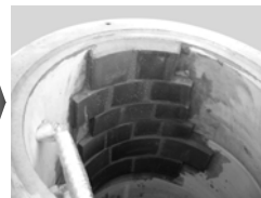
(斜壁・壁面完了状況)
