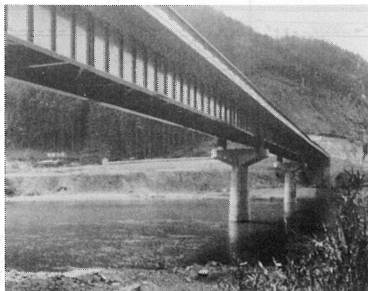
ロックドコイルロープにより合成された橋桁
