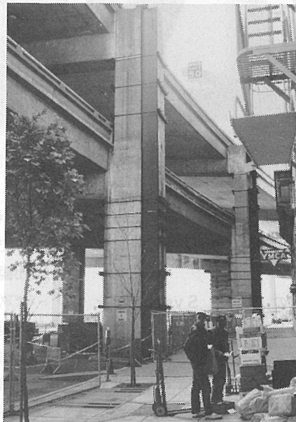
▲高架橋の補強
