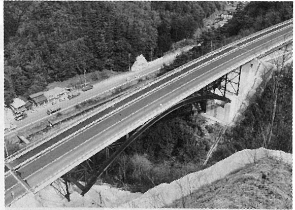
長期防錆型の塗装を行った橋桁
