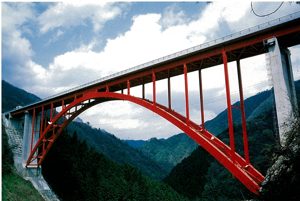
▲ 大平 2 号 橋 発注者 中国地方建設局 型 式 上路式ローゼ桁 橋 長 189m 幅 員 7 m 鋼 重 568 t 所在地 広島県山県郡加計町
