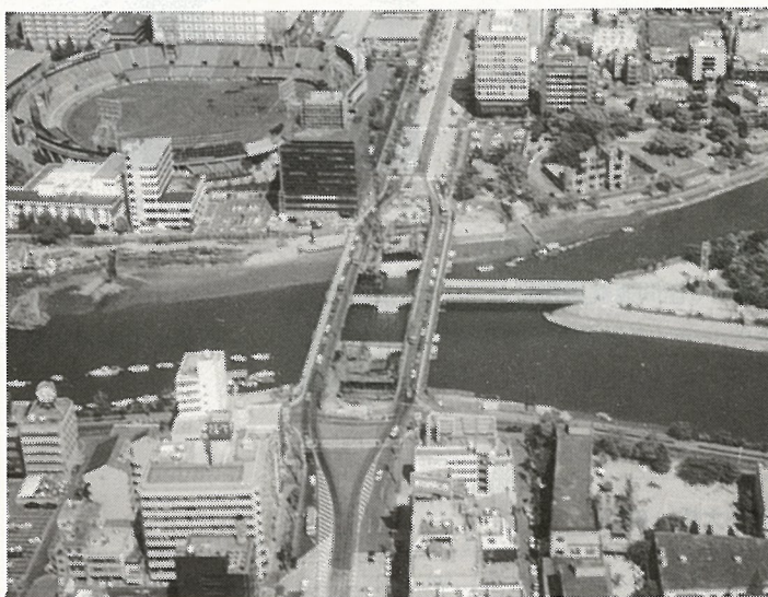
施工中の相生橋（昭和57年5月）
