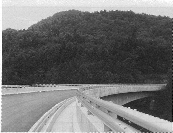
耐候性鋼材を使用した三井野大橋2号橋
