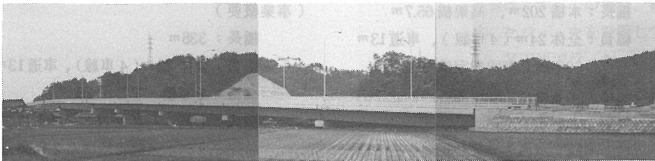
写真-2 徳尾大橋
