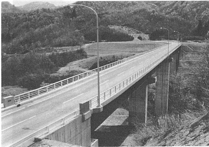
▲写真-9 布倉大橋
