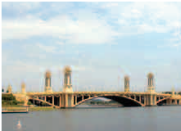
写真8 マレーシア新首都の橋(2)
