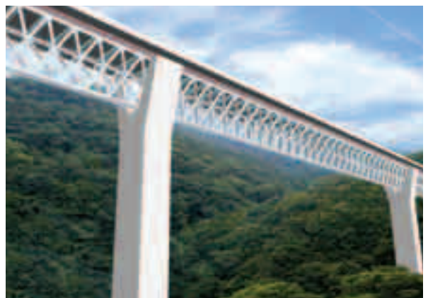
図3.12 三角断面ラチストラス橋の外観
