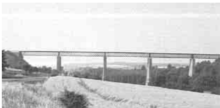
写真3.1 19世紀後半に欧州で建設されたラチストラス橋 (Bridges, Fritz Leonhardt, 1982より)
