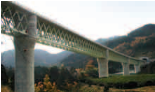
写真3.3 宮川橋の完成写真
