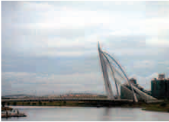
写真7 マレーシア新首都の橋(1)
