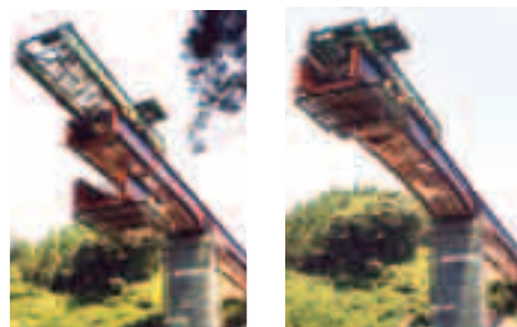
写真2.5 TEGクレーン張出し架設状況
