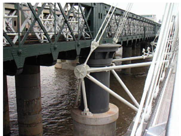
写真4 ハンガーフォード鉄道橋と橋脚
