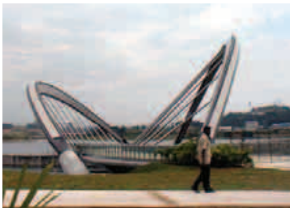
写真9 マレーシア新首都の橋(3)
