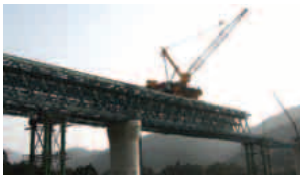
写真3.4 宮川橋の架設時
